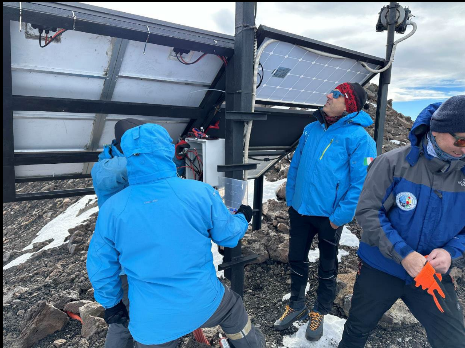
Attività di indagine svolte durante il sopralluogo di Novembre 2023
