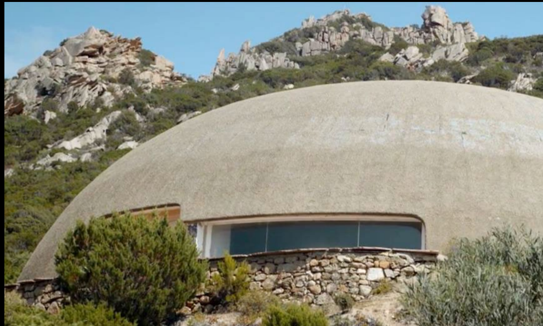
Villa Antonioni-Vitti, sistema Binishell di Dante Bini in Sardegna, Italia (Fonte: theplan.it ).
